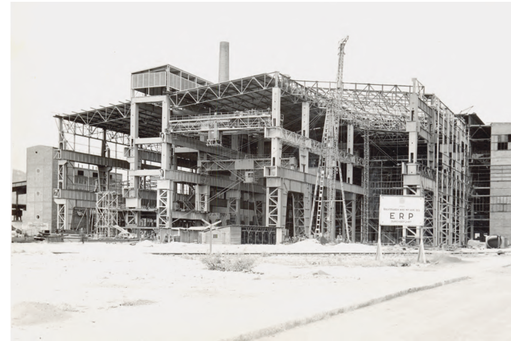
Baustelle des ersten LD-Stahlwerks der Welt in Linz
