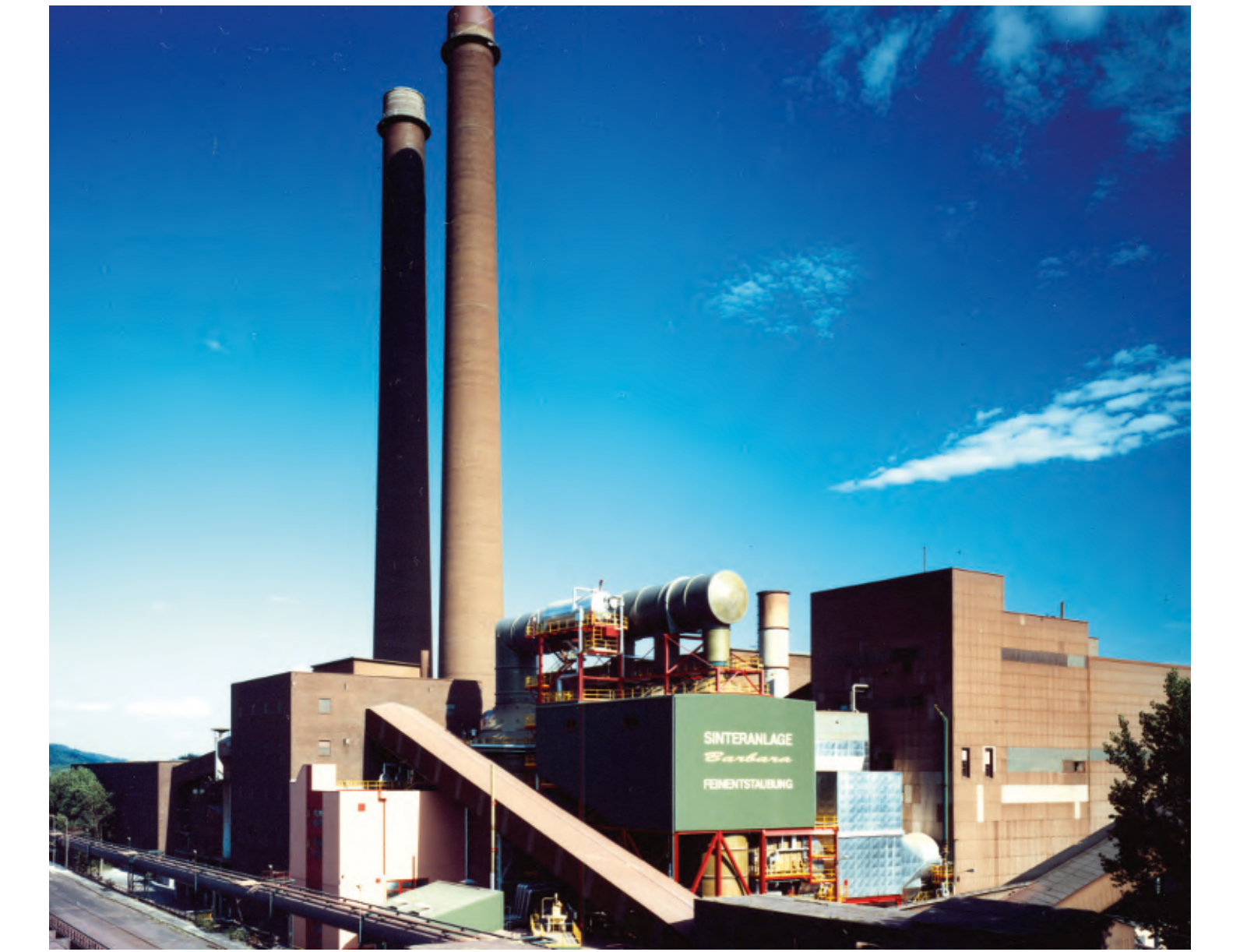
Fineststaubungsanlage Sinteranlage, Linz
